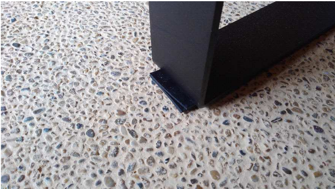
二種類のゴム材があるので鉄脚と床の間に挟んで使用する。
